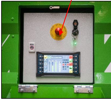
Not-Aus-Schlagtaster am Schaltschrank
